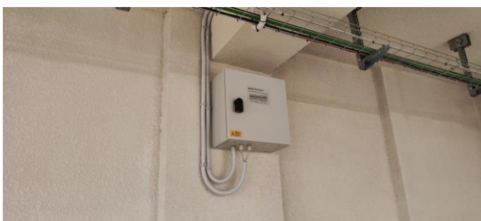
Submaster 1 im Akustik-Schutzgehäuse
